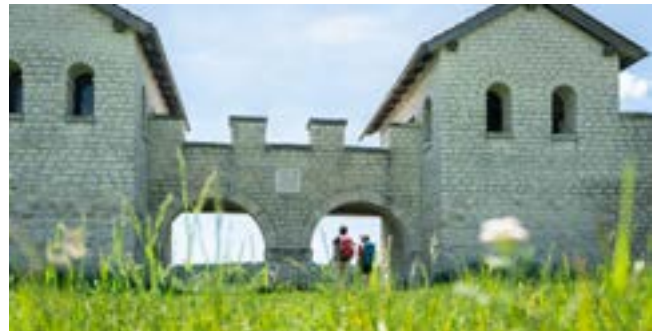
Abb. 3 | Das Kastell Pfünz hoch über der Altmühl beherbergte im 2. und 3. Jh. eine teilberittene Einheit mit etwa 500 Soldaten. Das teilweise nachgebaute Kastell ist ein beliebter Ausflugsort.
